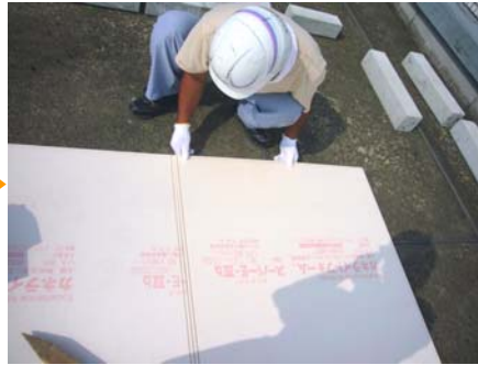
③防根断熱ボード施設
