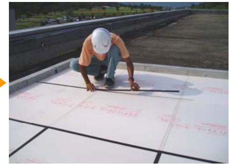
④ルートプロテクトジョイナー敷設
