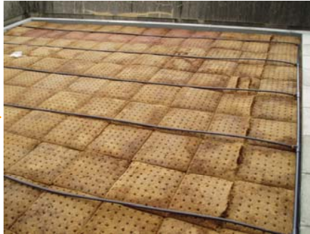
⑦灌水パイプ敷設
