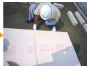
③防根断熱ボード施設
