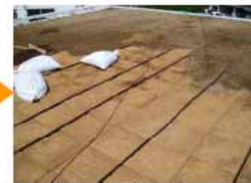
⑧kaisuitopミックス (リサイクルロード)敷設
