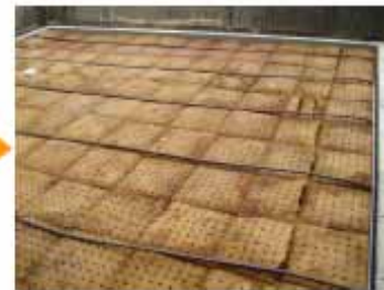
⑦灌水パイプ敷設
