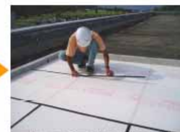
④ルートプロテクトジョイナー敷設
