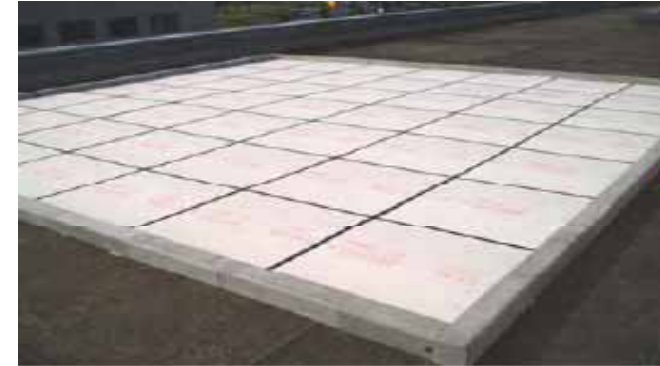
耐根断熱ボード施工時
