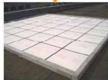
⑤防根断熱ボード ルートプロテクトジョイナー敷設完了
