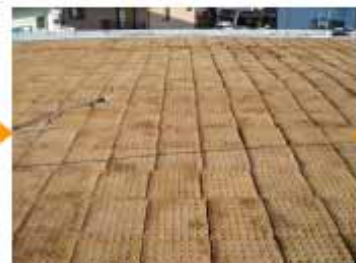
⑥木質系ボード(ガーデンマット)敷設
