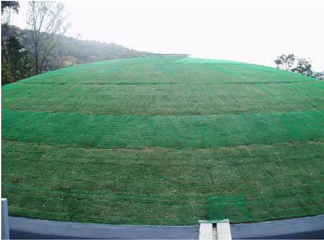
飛散防止ネット張り
